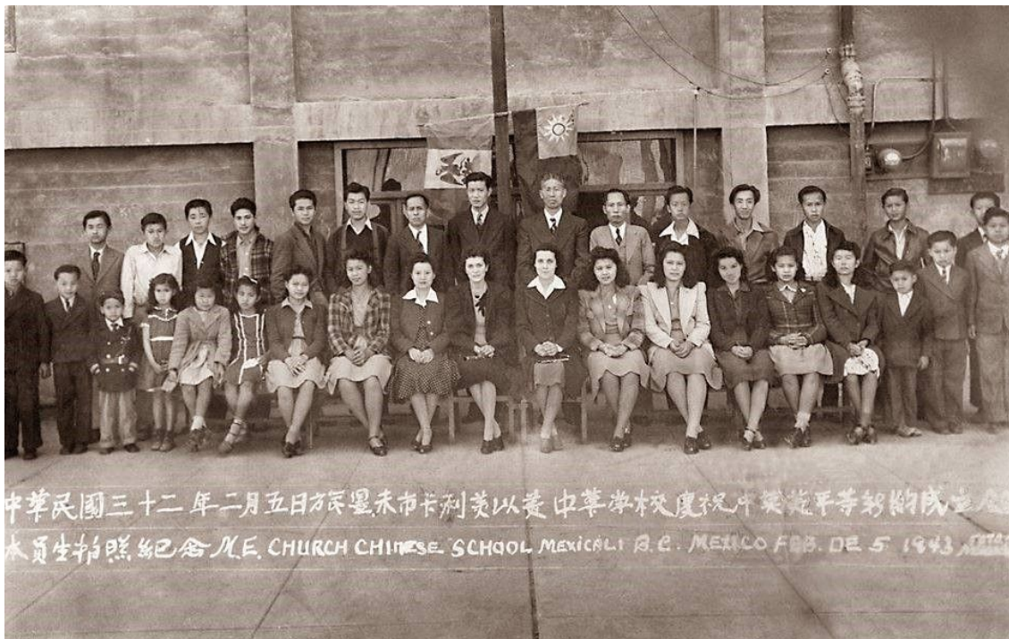
Iglesia e instalaciones de la escuela comunitaria. 1943. (Créditos: Col Asoc China de Mexicali)
